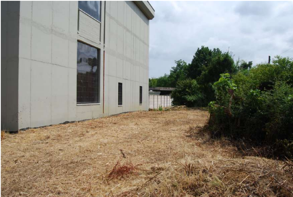
L'area di intervento sul retro dell'ampliamento del 2016
