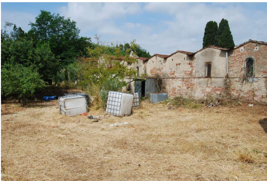
L'area di intervento sul retro delle cappelle della parte vecchia cimiteriale
